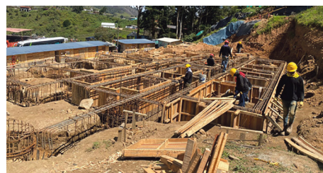
Construcción proyecto Sueños de Vida
