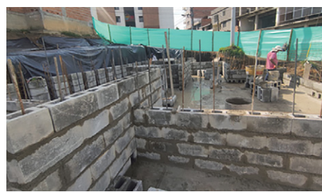
Construcción proyecto “Torres de la Transfiguración”
