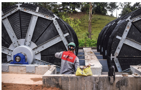
Sistema de Discos Biológicos Rotativos (CBR) – Foto: Alcaldía de Rionegro
