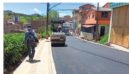
Pavimentación en barrio Conquistadores parte baja – Foto: Cortesía
