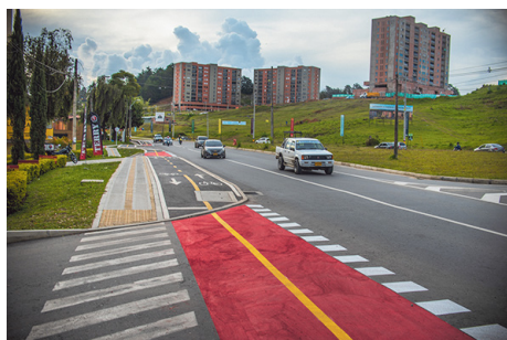
Vía doble calzada El Porvenir - Alto Vallejo
