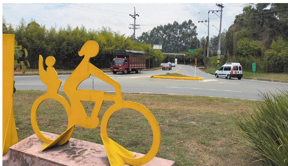
Glorieta El Yegüerizo, sitio donde se dará continuidad a la doble calzada
