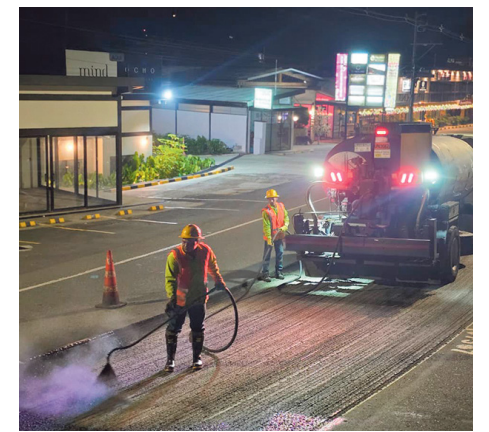
El material resulta del proceso de rehabilitación del pavimento en los corredores concesionados. - Foto: DEVIMED.
