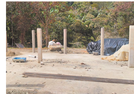
Inicio de la reconstrucción del lugar mediante convites y con mano de obra local. - Foto: Cortesía
